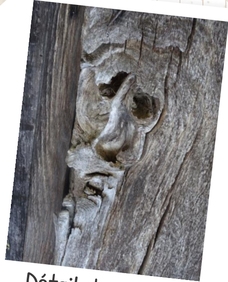
Détail de porte
