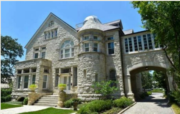
Oge House San Antonio
