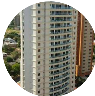
EDIF. RESIDENCIAS FIORANO
