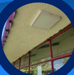
CAMBIO ALEROS PABELLÓN 1
