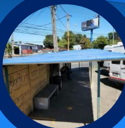
CAMBIO TECHO ESTACIONAMIENTOS
