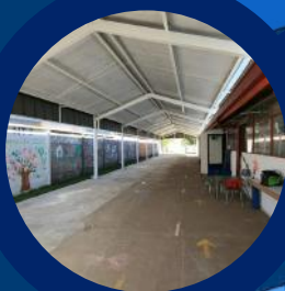
CAMBIO TOTAL TECHO NIVEL INICIAL
