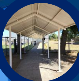
CONSTRUCCIÓN PASILLO A GIMNASIO
