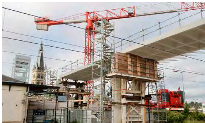
Deux travées ont été posées dans les nuits du 1er et 2 septembre. © l'Hebdo du Vendredi
