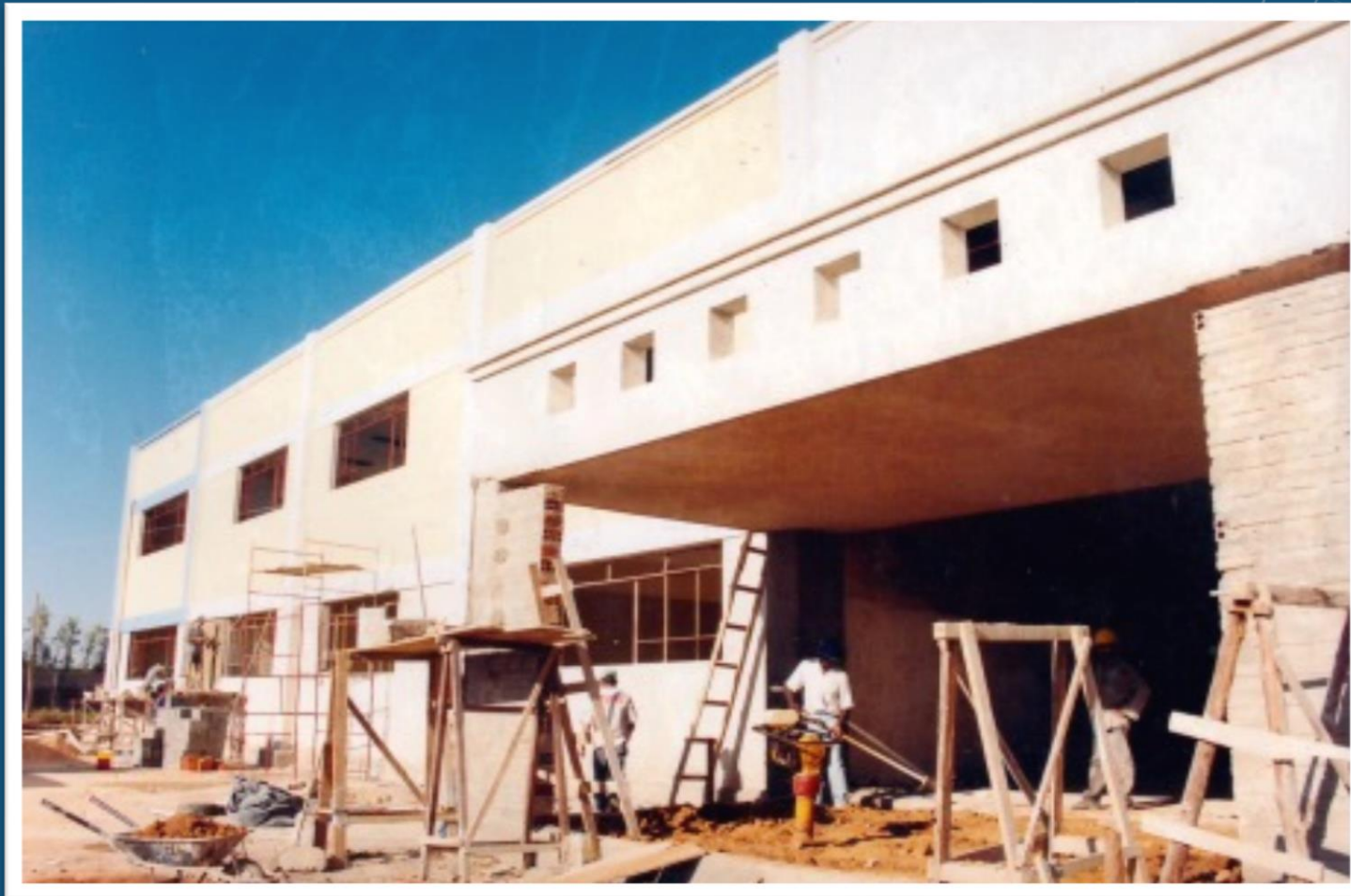
Obras do prédio para a PUC Acervo de Janer Faria
