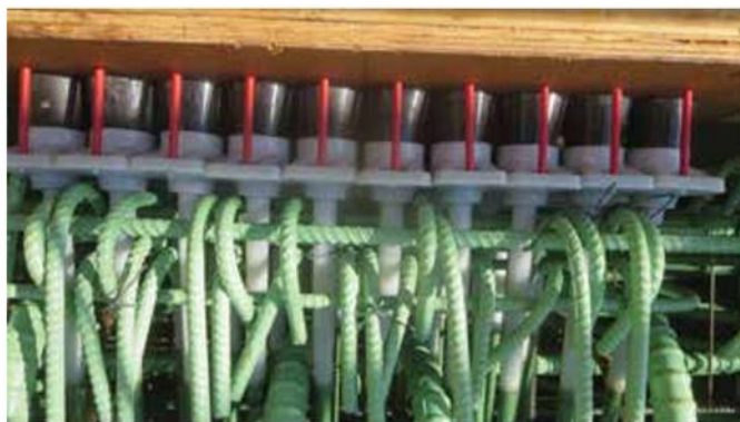
Fig. 1: Ejemplos de refuerzo que desafiaron la colocación para el contratista: (a) un muro sismorresistente; y (b) una zona de anclaje para torones de postensado.
