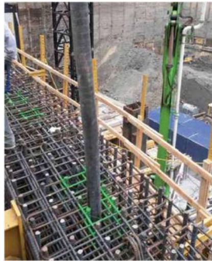
Fig. 3: Zonas de acceso a la manguera de la bomba y al vibrador (pintura verde) en la parte superior de un muro de corte congestionado. Estas zonas estaban espaciadas a 3 metros sobre la parte superior del muro y eran continuas en toda su altura. Las zonas se coordinaron previamente con el ingeniero y la agencia de inspección.
