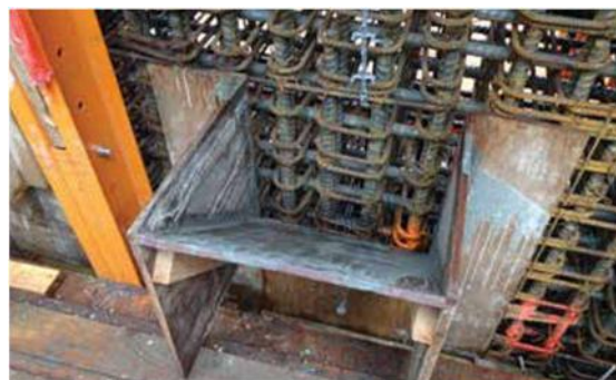
Fig. 5: Canaleta portátil de colocación de concreto, de 40cm de ancho por 30cm de profundidad, utilizada en la parte superior del muro para permitir la colocación de SCC a través del lateral del muro de corte congestionado. Se saltaron varias canaletas de madera construidas en obra para mantenerlas delante del equipo de colocación. Los núcleos de prueba previos a la construcción, tomados a través del acero de refuerzo en la parte inferior de los elementos de contorno congestionados, indicaron que no había separación de agregados.
