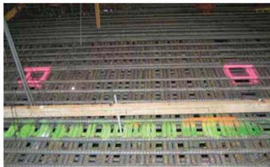
Fig. 4: Zonas de acceso a la manguera de la bomba (pintura rosa). Estas zonas tenían un área de 15 cm y estaban espaciadas entre 2,4 y 3m. Normalmente, las barras superiores de ambas capas se desplazaban a la posición de diseño correcta y se aseguraban tras completar el bombeo de la capa inferior. El desplazamiento temporal del refuerzo de la capa superior se coordinó previamente con el ingeniero y el área de inspección.
