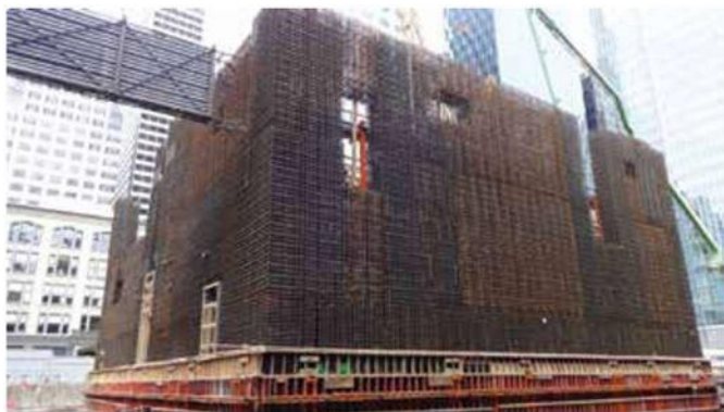
Fig. 1: Ejemplos de refuerzo que desafiaron la colocación para el contratista: (a) un muro sismorresistente; y (b) una zona de anclaje para torones de postensado.
