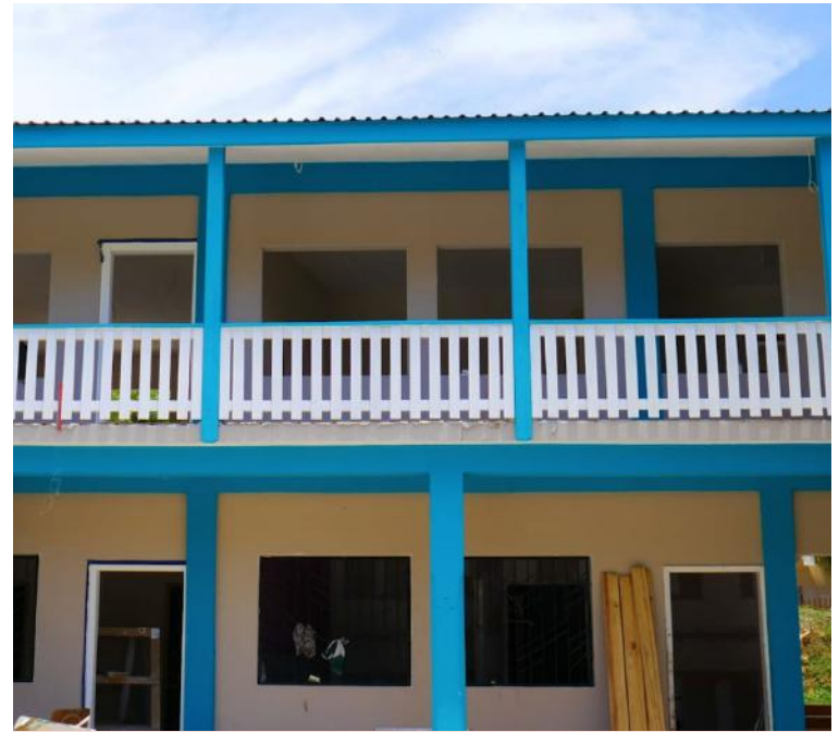
Fachada por fuera de como esta quedando el centro de salud.
