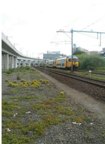
Ballastbed met Gele helm- bloem bij Amsterdam-Sloterdijk
