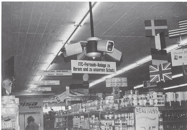
Ladenüberwachungsanlage mit Drehsternen in einem Selbstbedienungsgeschäft, ausgeführt durch die H. K. Schibli AG.
