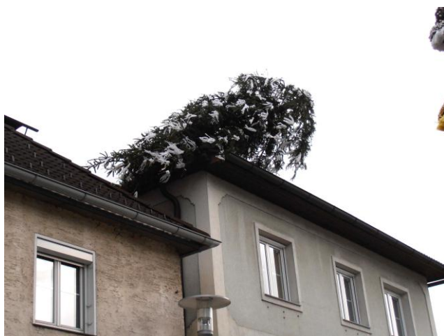
Der Sachschaden hielt sich glücklicherweise in Grenzen
