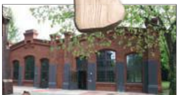
Das Pumpenhaus am Salbker Wasserturm
