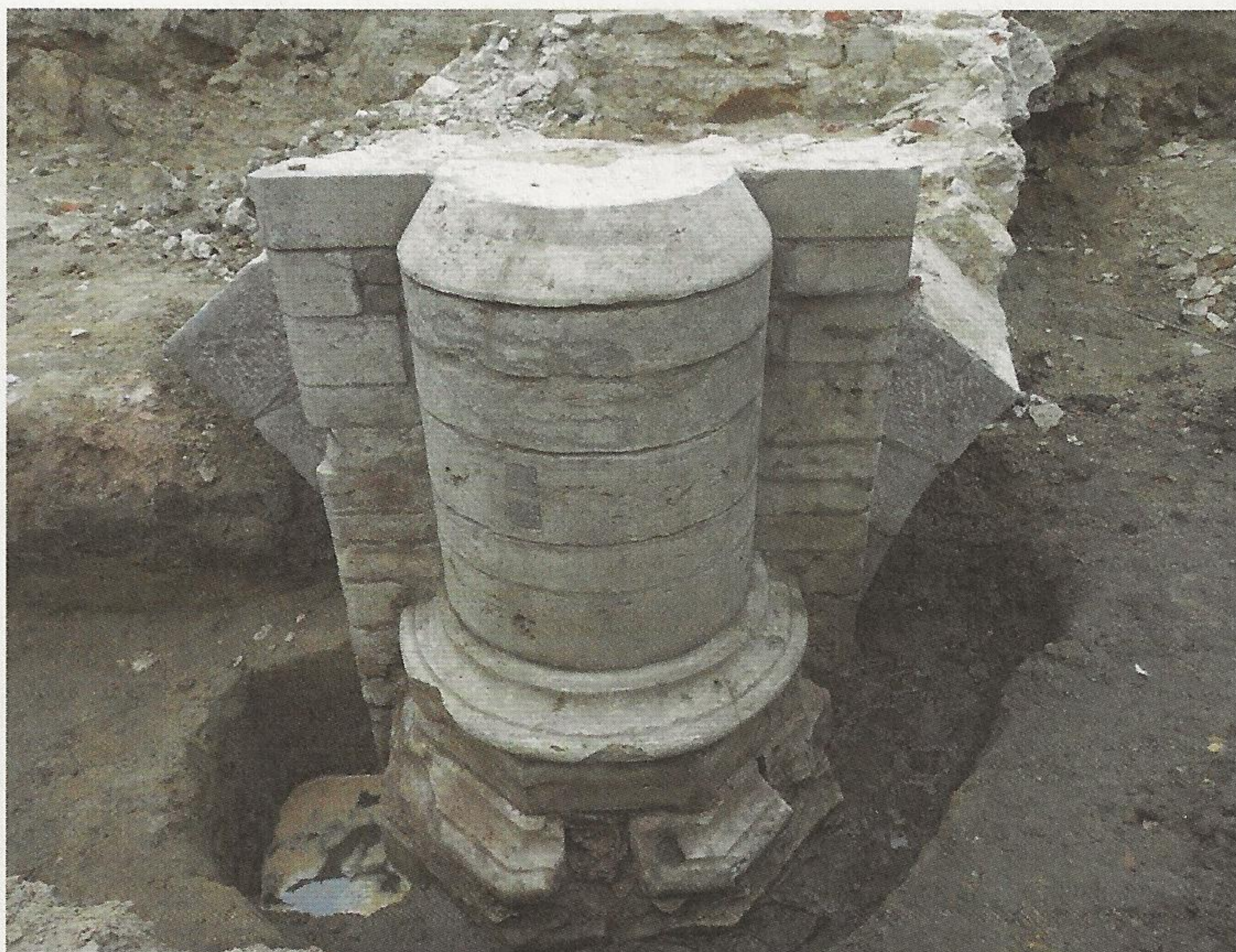
Middelste brugpijler van de schipbrug met de halfzuil uit kalkzandsteen en de boogstenen uit blauwe hardsteen. Daarachter de kern uit brokken (© Stad Leuven).
