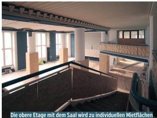
Die obere Etage mit dem Saal wird zu individuellen Mietflächen
