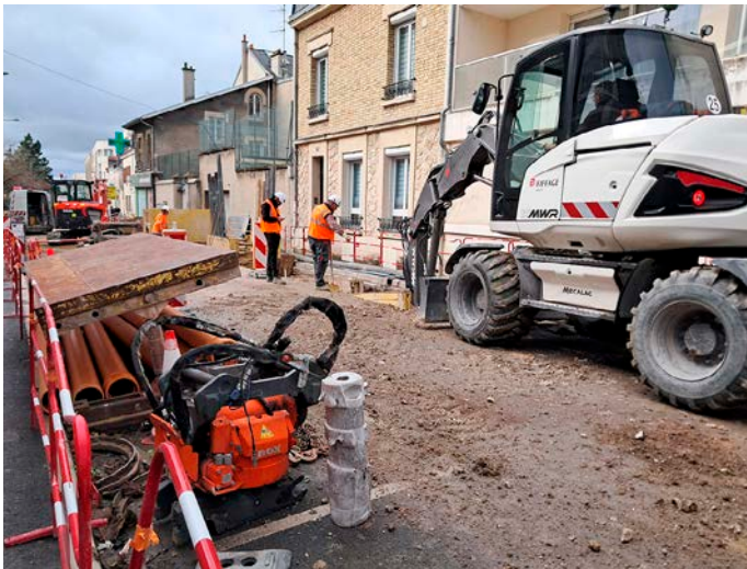
Ouvriers et techniciens s'affairent à changer la canalisation bouchée dans la rue des Carmes. © l'Hebdo du Vendredi
