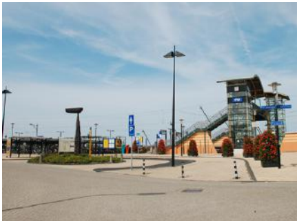
Station Hillegom (type Basis), toegangspoort tot het netwerk.
