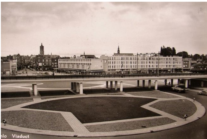
Het doorlopende maaiveld maakt dat de spoorlijn nauwelijks als barrière wordt ervaren
