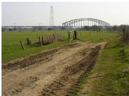
De spoorbrug bij Oosterbeek over de Nederrijn.
