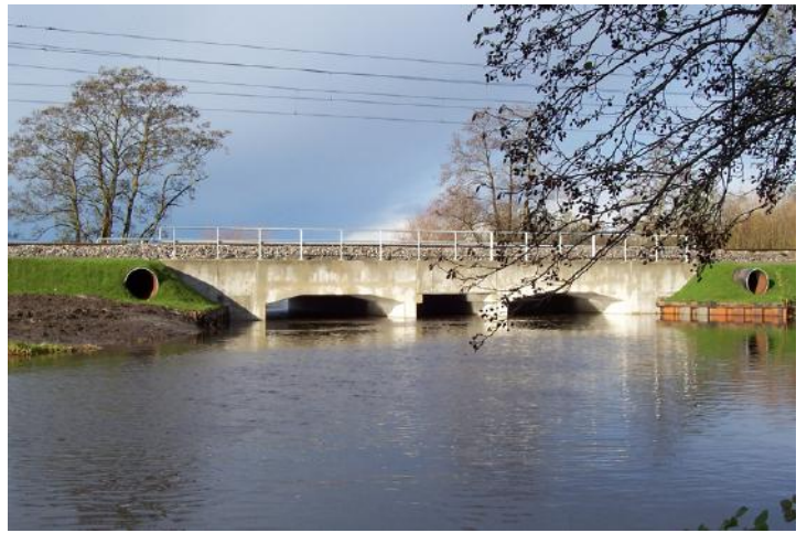
Nieuwe brug over de Drentsche Aa: door kleine openingen kun je de loop van het water niet zien.
