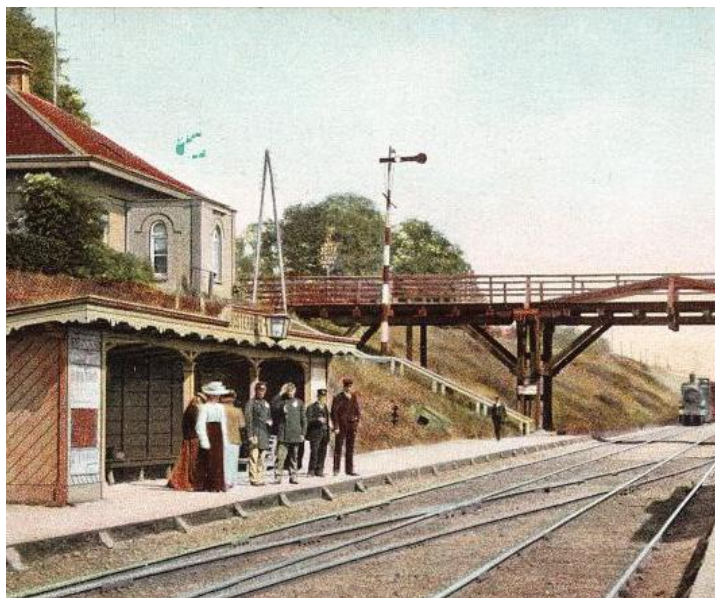
De taluds bij station Oosterbeek lijken vroeger te zijn ingeplant met heide
