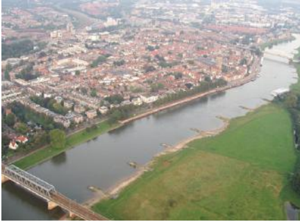
Spoorbrug over de IJssel bij Deventer
