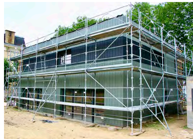
Les constructions seront à énergie positive. © l'Hebdo du Vendredi
