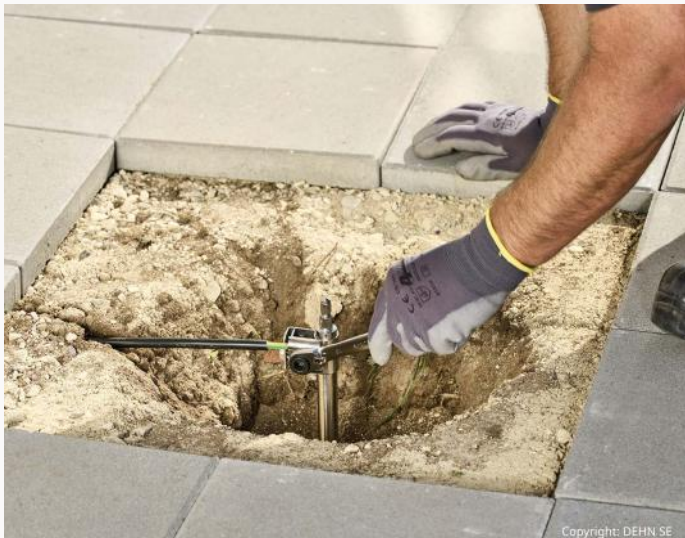
Erdungsanlagen mit Tieferdauern sind die ideale Lösung für Bestandsgebäude – mit oder ohne Keller.
