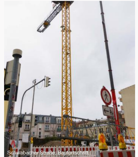
Schwabacher Straße, Baufortschritt
