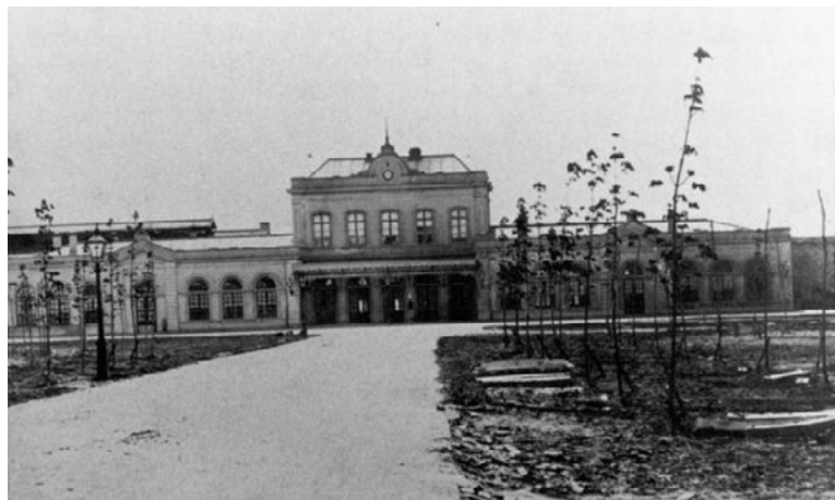
Afb. 3.2.2 Station Leeuwarden, in circa 1870 gezien vanaf de pas aangeplante Sophialaan. De laan komt in ontwerp uit op het hoofdvolume van het station.
