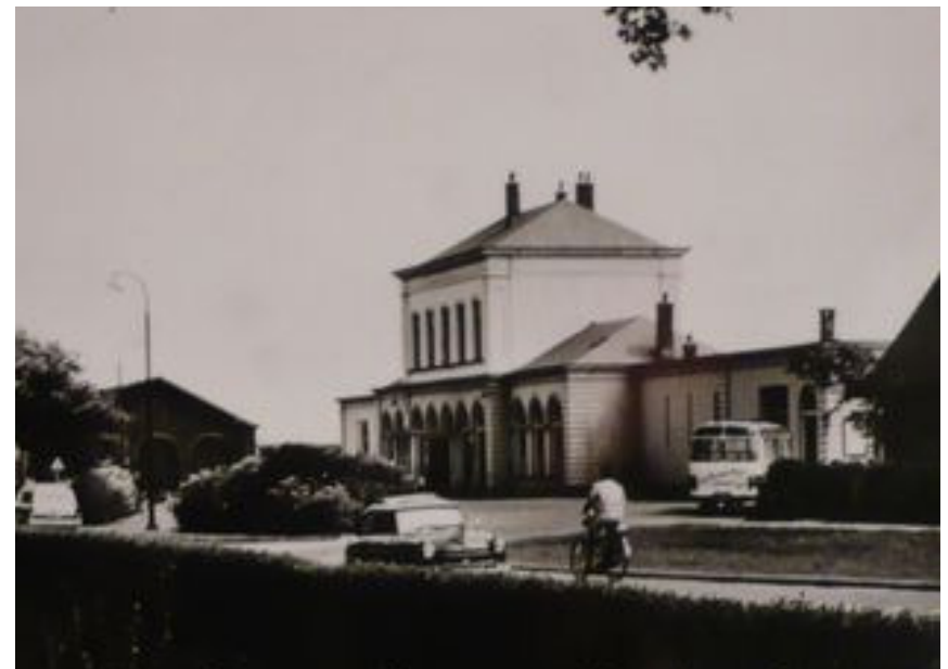
Afb. 2.4.21 Het station rond 1960. In de westvleugel (rechts) met het platte dak zijn aan de straatzijde drie smalle ramen aangebracht. Op de voorgevel is de klok verdwenen en een strakke daklijst geplaatst.
