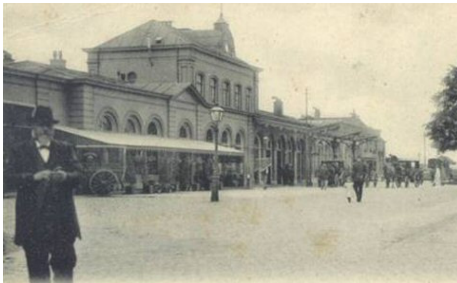
Afb. 2.4.12 Station Leeuwarden rond 1900. De vergrote vleugels zijn goed zichtbaar, de bovenwoning in het hoofdvolume is nog intact.
