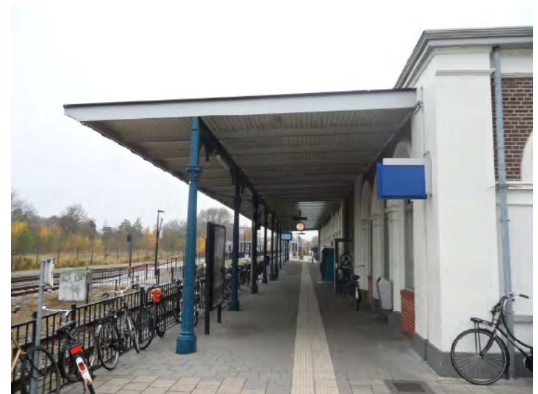
Afb. 5.3.12 De perronkap te Winschoten, met de eenvoudiger uitvoering van de gietijzeren constructie.
