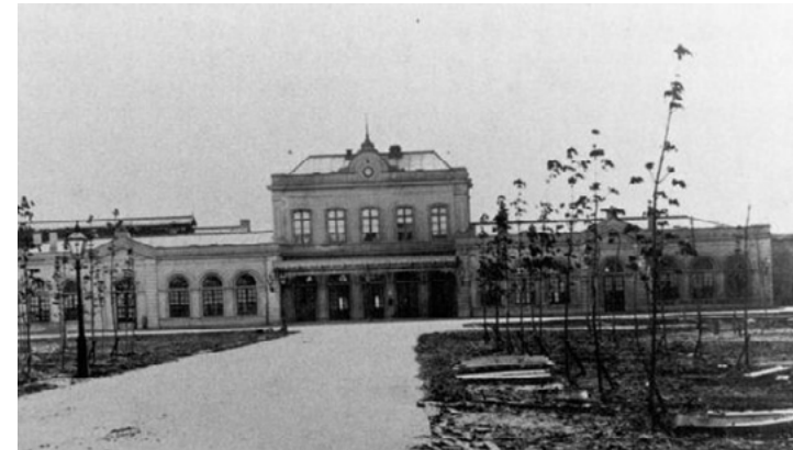
Afb. 2.3.3 Station Leeuwarden, in gebruik genomen 27 oktober 1863, foto 1870
