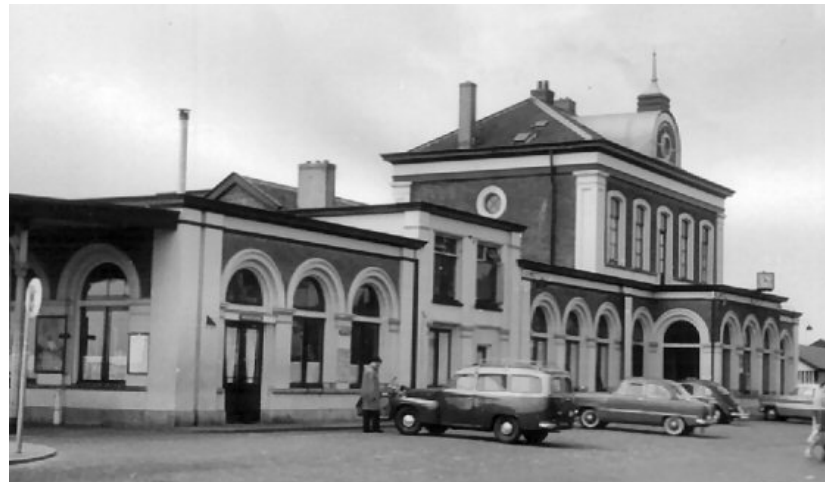
Afb. 2.4.31 Aanzicht van het station voor modernisering van 1971. Links midden in de oostvleugel de uitbouw van de woning, voor de hoofdentree is het oude voorportaal zichtbaar met moderne stationsklok. Foto 1970.
