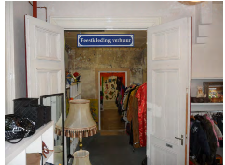
Afb. 5.3.27 Originele binnendeuren naar de westelijke ruimtes.
