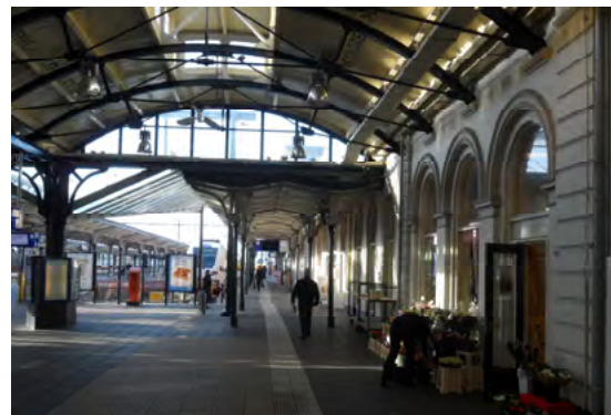
Afb. 4.2.21 Overgang van het centrale perron naar perron 1.
