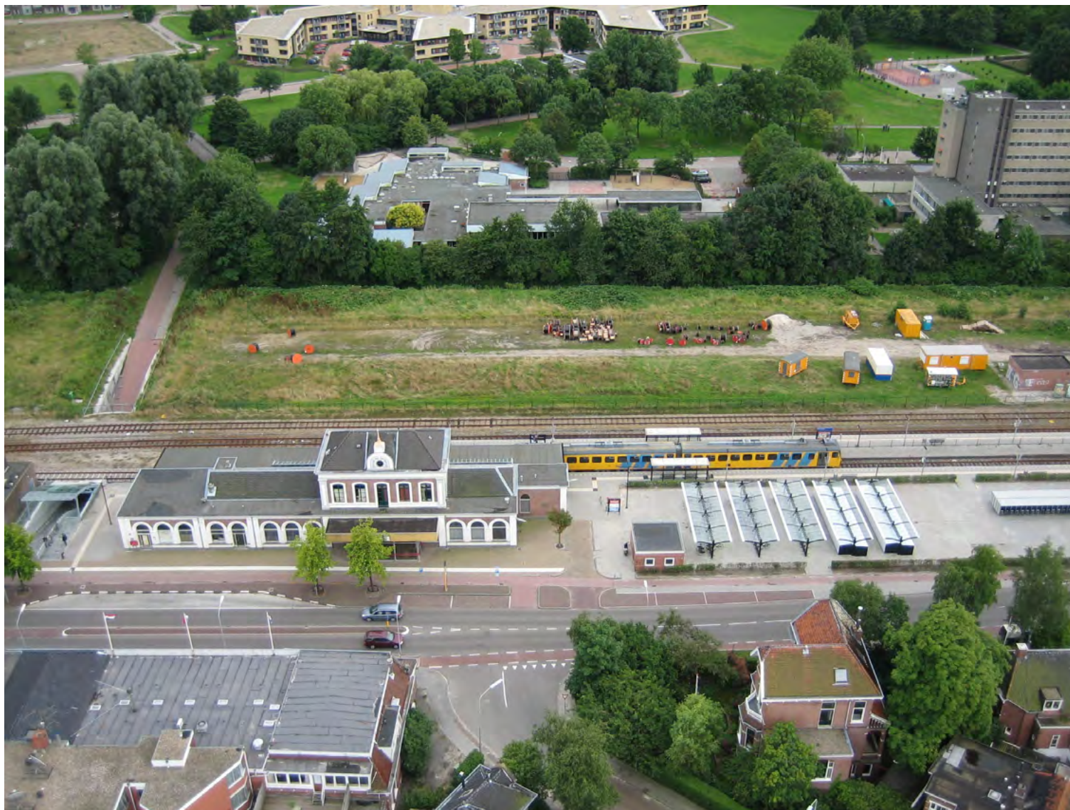
Afb. 4.1.3 Luchtfoto van station Winschoten, met emplacement, voor de restauratie van het gebouw. Op de achtergrond het uitgebreide terrein van het vroegere emplacement. Foto J. Zuidema, 2005
