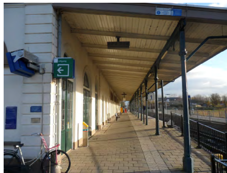
Afb. 5.3.6 De verlichtingsbakken onder de perronkap te Harlingen.
