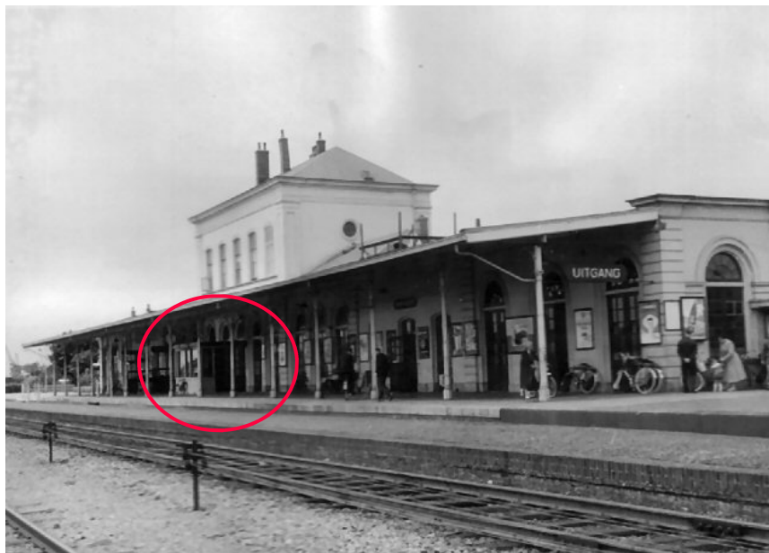
Afb. 2.4.20 Op het perron is aan het plaatskaartenkantoor een uitbouw geplaatst. Vermoedelijk gebeurde dit kort voor 1950.
