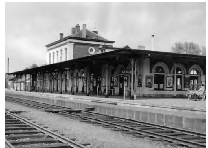
Afb. 2.4.26 Winschoten aan de perronzijde in 1970. Rechts is de perronkap zichtbaar die doorloopt langs de zijgevel van de oostvleugel.
