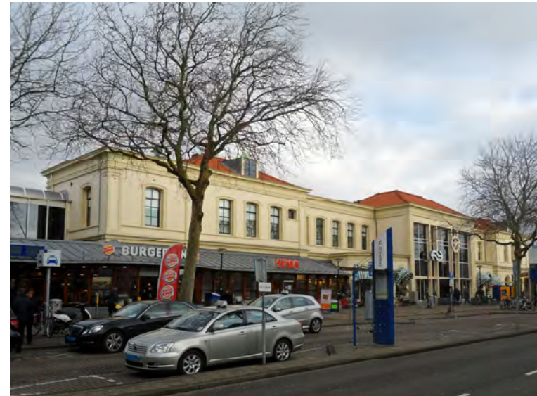
Afb. 2.4.1 Het huidige aanzicht van station Alkmaar. De verschillende gebruikers van het stationsgebouw strijden om de aandacht.
