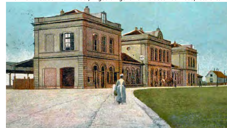
Afb. 2.3.5 Station Alkmaar, in gebruik genomen 20 december 1865. Foto circa 1900, met verbouwde vleugelpaviljoens uit 1879.
