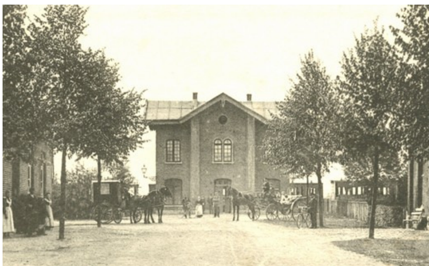
Afb. 2.2.3 Voorbeeld van een station 5e Klasse, station Reuver (gebouwd 1863). Foto circa 1900
