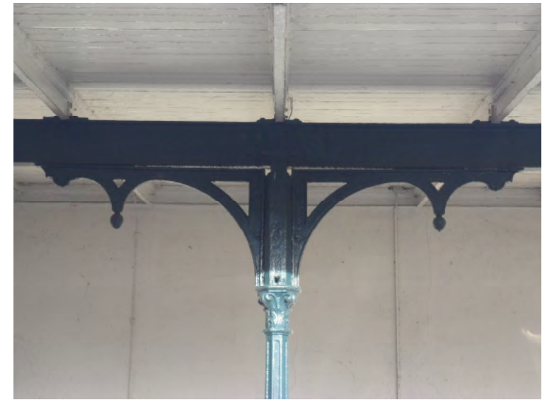
Afb. 5.3.13 De perronkap te Harlingen, met de eenvoudiger korbelen die de draagbalk ondersteunen.
