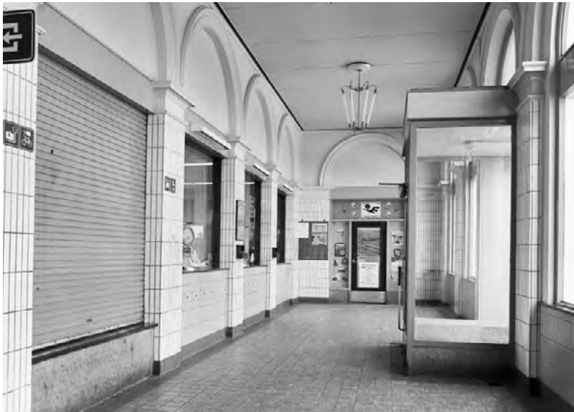
Afb. 2.4.17 De vestibule van station Harlingen in 1973. De nieuwe loketwand is tussen de oude rondbogen geplaatst. Het plafond is vervangen en voorzien van nieuwe verlichtingsarmaturen. Foto Beeldbank RCE
