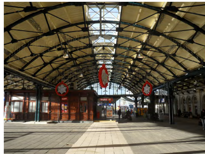
Afb. 4.2.23 Het centrale perron van Leeuwarden met de grote perronkap, gezien naar het westen. Rechts het stationsgebouw, links een houten perrongebouw.
