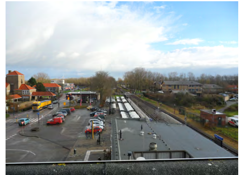
Afb. 4.2.18 Zicht op het oostelijk emplacement met parkeerplaats en rijwielstalling, gezien vanuit de zolder van het hoofdvolume.
