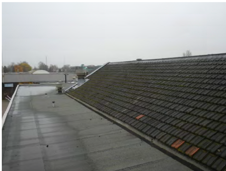
Afb. 5.3.3 Dakbedekking te Winschoten; de schuine delen met dakpannen, de vlakke delen met asfaltbitumen.
