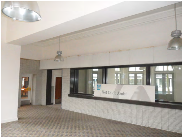
Afb. 5.3.14 Het voorhuis te Winschoten, met jaren '60 loketwand en betegelde muren en vloeren. Het plafond voor de loketwand heeft de oude sierstuc afwerking.
