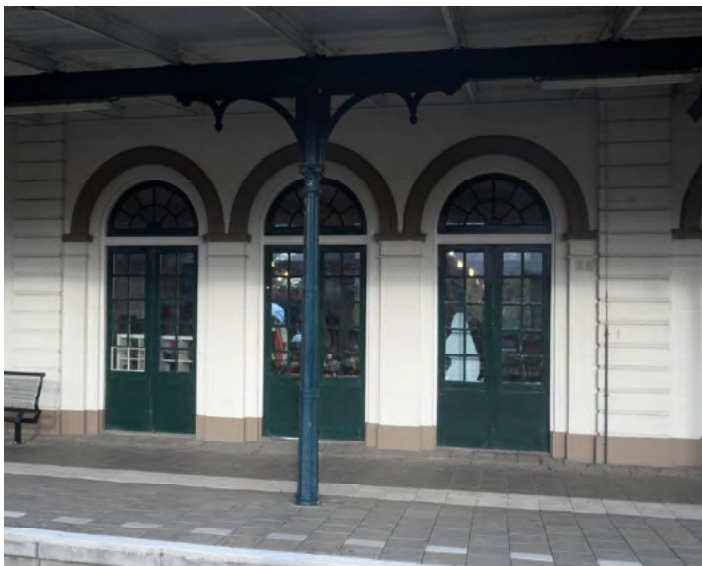
Afb. 5.3.8 De originele deurstellen aan de perronzijde in de westvleugel.
