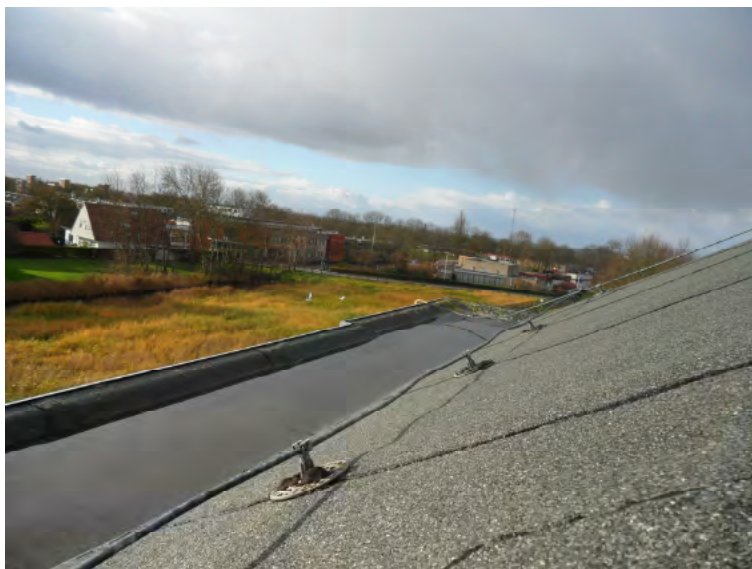
Afb. 5.3.4 Dakbedekking te Harlingen; de schuine en vlakke delen met asfaltbitumen.
