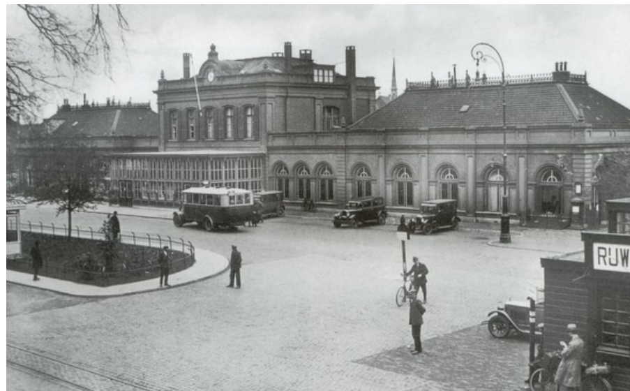
Afb. 2.4.14 Station Tilburg rond 1930. De vleugels zijn sterk vergroot en hebben verhoogde daken. Voor de hoofdentree is een volumebrede voorhal geplaatst.
