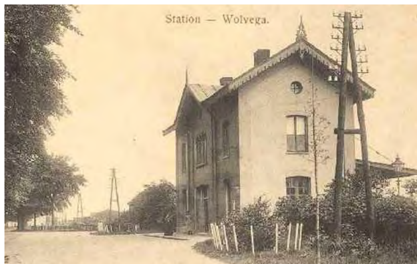
Afb. 2.2.2 Voorbeeld van een station 4e Klasse, station Wolvega (gebouwd 1865). Ansichtkaart circa 1910
