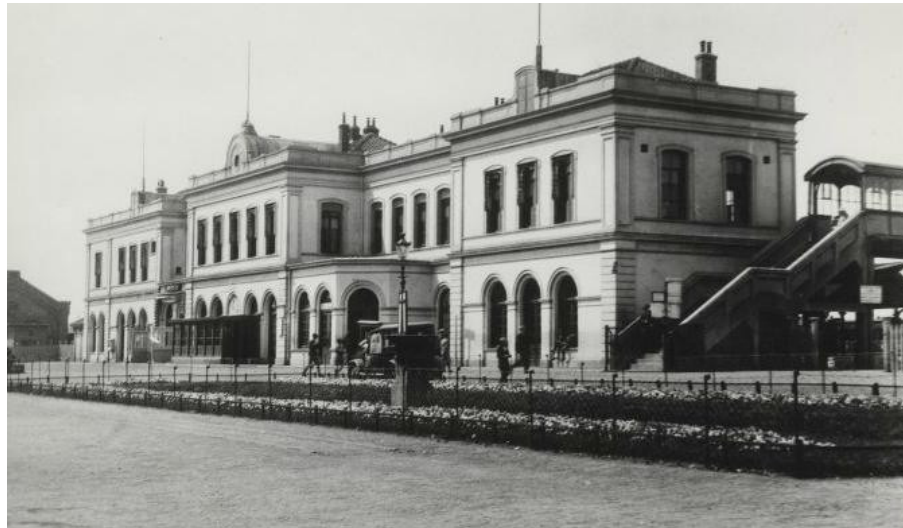
Afb. 2.4.13 Station Alkmaar rond 1920. Van het oorspronkelijke type is het hoofdvolume nog redelijk herkenbaar.
