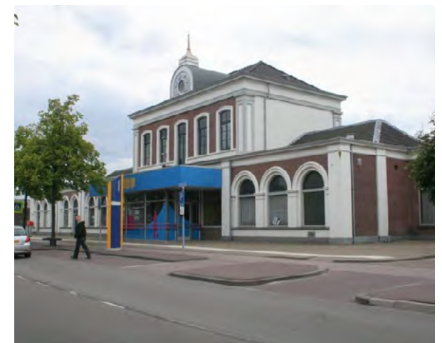
Afb. 2.4.32 Voorgevel van het station in 2009, met de voorhal uit de jaren '70.
