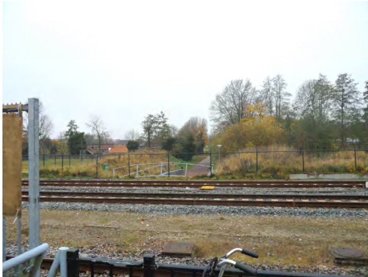
Afb. 3.2.9 Winschoten, tunnel-uitgang aan de zuidzijde, gezien vanaf het perron.
