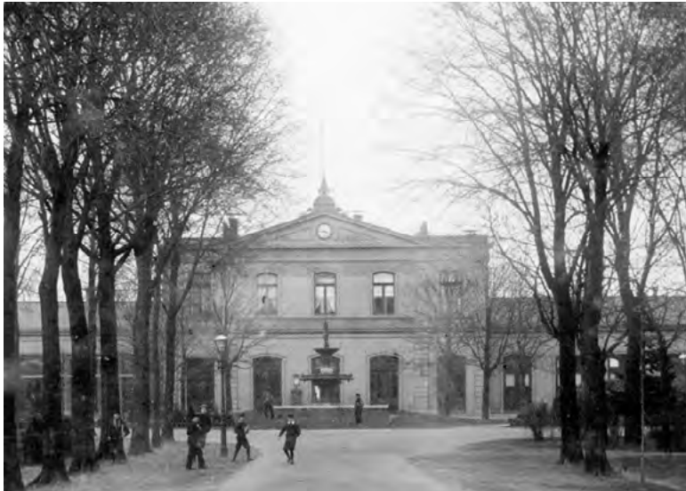
Afb. 5.2.3 De tweede uitvoering van het type; Station Meppel, rond 1910. De fronton met ornamenten is zichtbaar. Na oorlogsschade is het gebouw versoberd herbouwd. Bij de restauratie door Van Kilsdonk is de uitgekleden versie van het ontwerp gehandhaafd.
