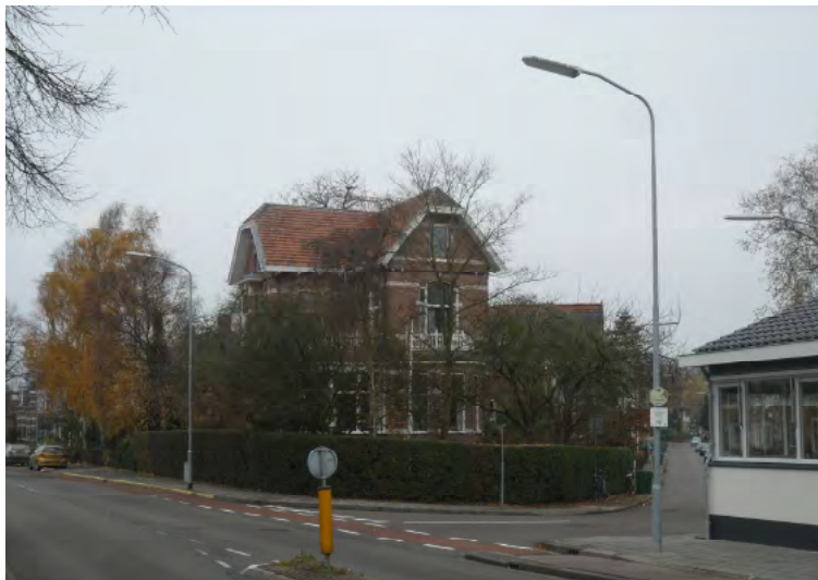
Afb. 3.2.4 Rechts het begin van de Stationsstraat met villabebouwing, gezien vanaf het station. Op de voorgrond de Stationsweg.
