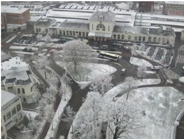
Afb. 3.2.3 Het station van Leeuwarden en de omringende infrastructuur, gezien vanuit de Achmeatoren. Op de voorgrond de Sophialaan. Foto P. Venema, 2010
