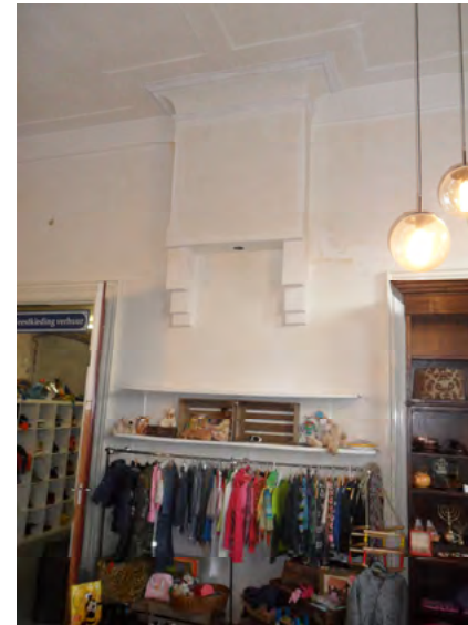
Afb. 5.3.30 De schouw tegen de westwand, met gat voor de kachelpijp.
