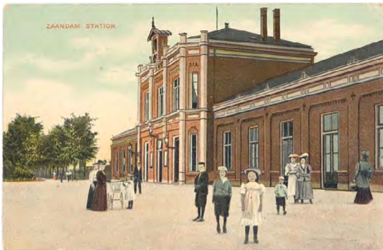
Afb. 5.2.4 De derde uitvoering van het type 3e Klasse; station Zaandam. Standaard zijn de afgeschuinde hoeken en de geprofileerde daklijsten, bijzonder is hier de haast neogotische detaillering van de pilasters. Ingekleurde ansichtkaart 1914
