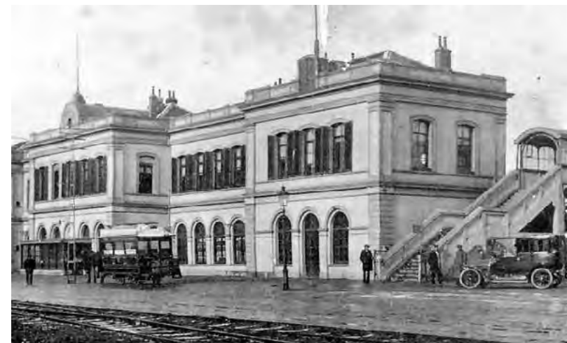
Afb. 4.2.14 Station Alkmaar rond 1910, met rechts de voetgangersbrug naar het tweede peron.
