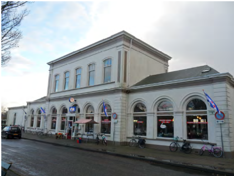
Afb. 5.3.2 De voorgevel van station Harlingen.
