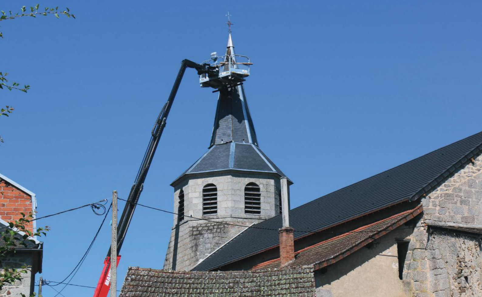
Réparation de la toiture de l'église
