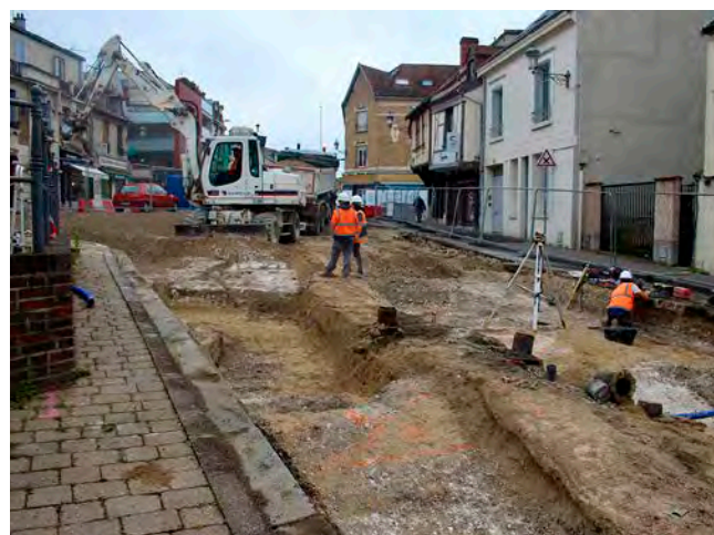
Les fouilles sont terminées, mais des travaux de confortement pourraient prendre le relais. © l'Hebdo du Vendredi
