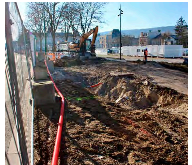
Les ouvriers ont entamé le terrassement du futur parc du Jard. © l'Hebdo du Vendredi
