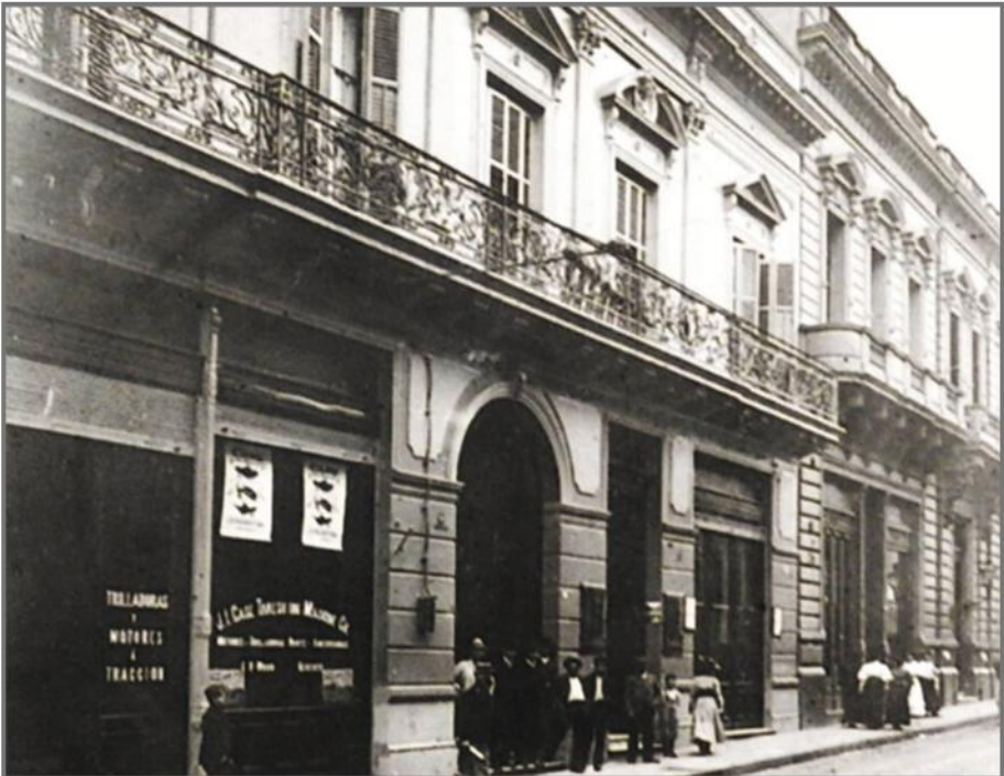
Fachada de la English High School (calle Perú)
