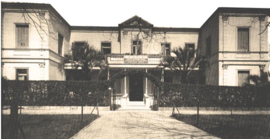
Av. Melián 1880. El histórico edificio que construyó Hutton pensado como vivienda y que luego se reestructuró para contener aulas, administración y posteriormente su Museo
