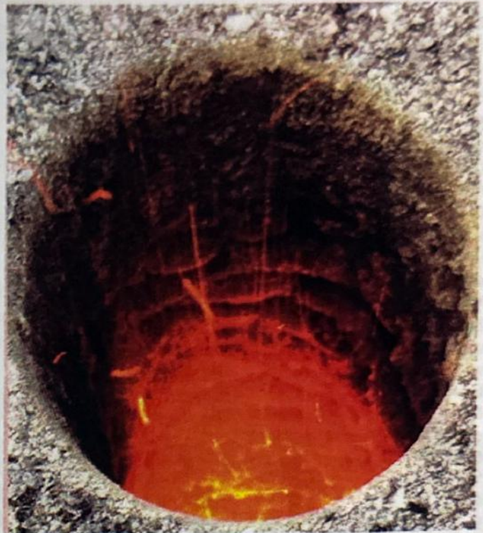
Blick in einen brennenden Kamin – Wasser ist in diesem Falle tabu!
