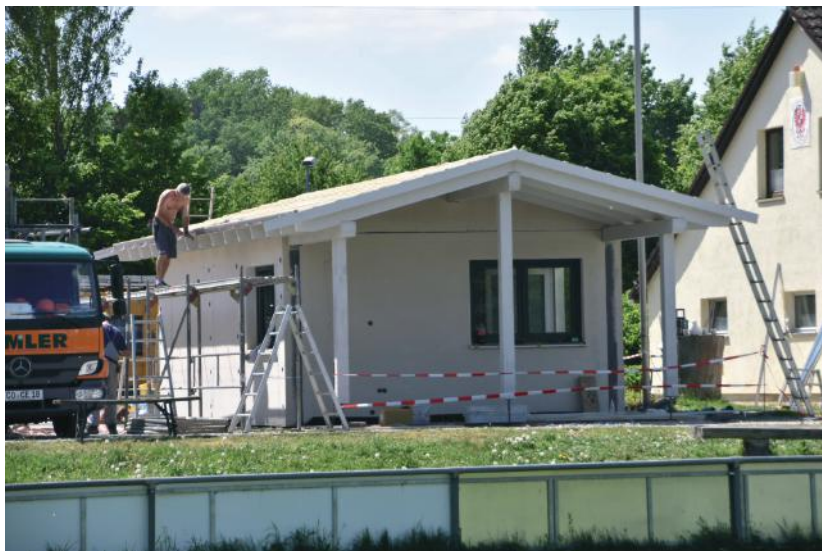
Der Bau des „Wolfhaus“ im Jahr 2018
