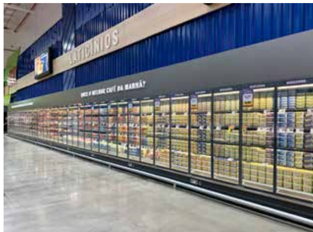
Figura 3: Expositor incorporado com compressor e condensador na parte inferior (Eletro frio Refrigeração)
