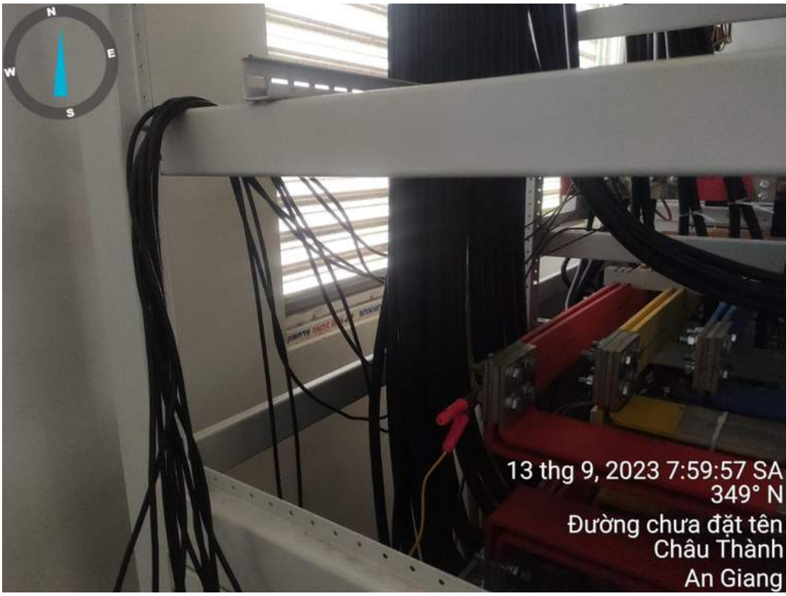
Agimexpharm (An Giang) - Đo chất lượng điện năng (Kiểm tra phát ngược)
