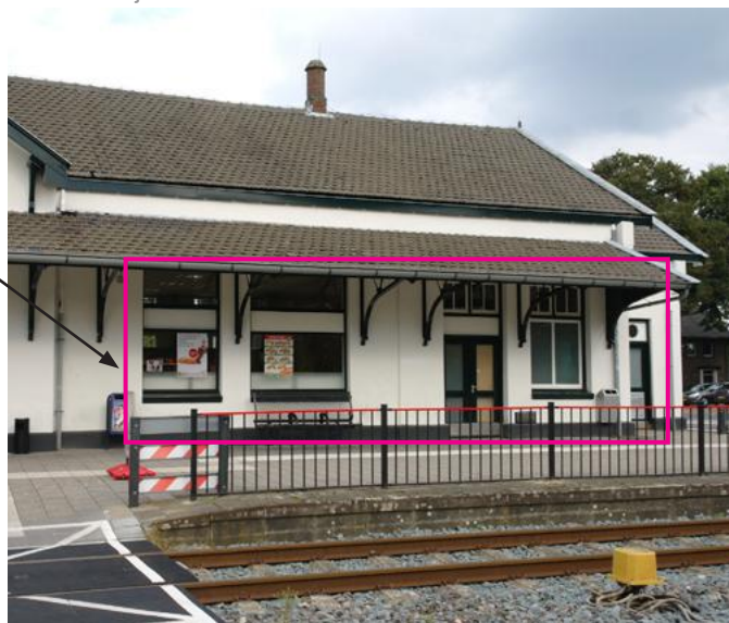
Afb. 4.45: achtergevel, de voormalige reizigersvleugel met de wachtkamers
