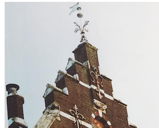
Afb. 4.15: Trapgevel met windvaan station Kesteren
