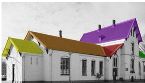
Afb. 4.1: Aanzicht oostgevel (voorzijde met aanduiding volumes)
