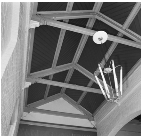
Afb. 4.7: Zadeldakconstructie in vestibule
