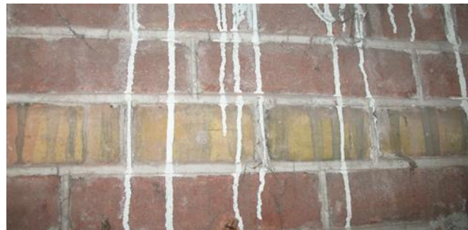
Afb. 4.25: Schoonmetselwerk in de vestibule
