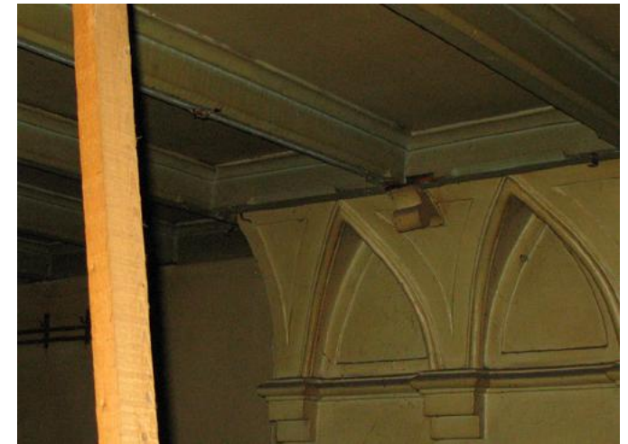
Afb. 4.27: Plafond in het voormalige kantoor
