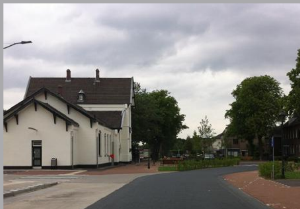
Afb. 2.15: Het station vanuit het zuiden, foto 2013
