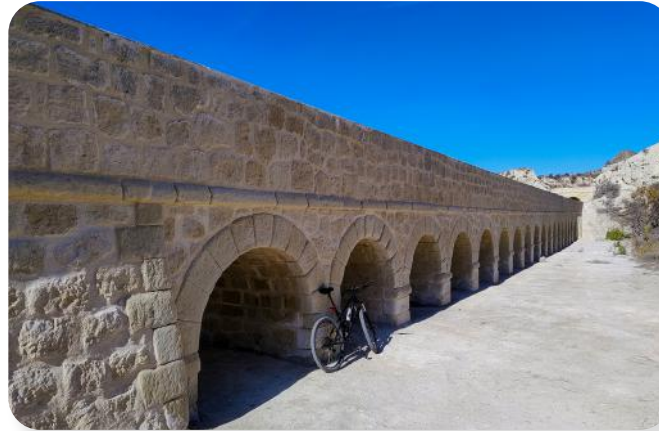
Primero de los acueductos al empezar la pista sin asfaltar
