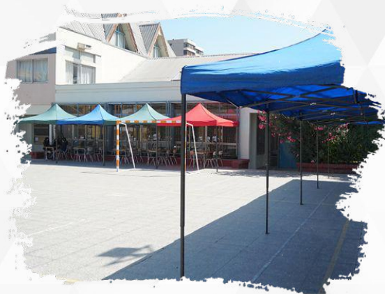
Instalación de toldos para ampliar el sector de almuerzo de estudiantes, donados por el Centro de Padres.
