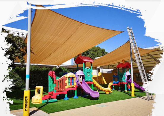
Compra e instalación de nuevos Toldos para el patio de Ed. Parvularia.
