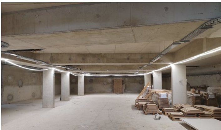
Fig. 2: Solo la cimentación, sótano y losas de piso fueron construidos con concreto convencional para cumplir con propiedades mecánicas requeridas que no se lograban con concreto reciclado (foto cortesía de INGÉ-A)
