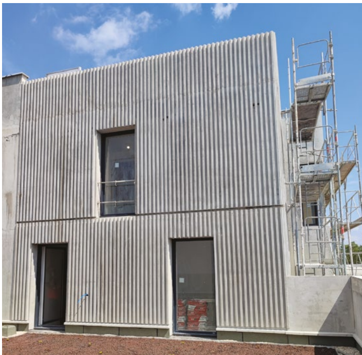
Fig. 3: Los muros de carga fueron revestidos con una variedad de terminados, incluyendo tableros de terracota (foto cortesía de INGÉ-A)
