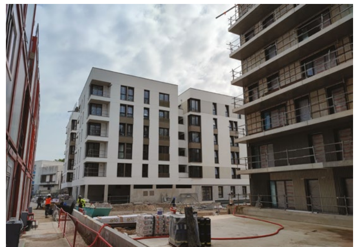
Fig. 1: Construcción de edificio para el proyecto Recygénie fabricado con concreto 100% reciclado. (foto cortesía de INGÉ-A)
