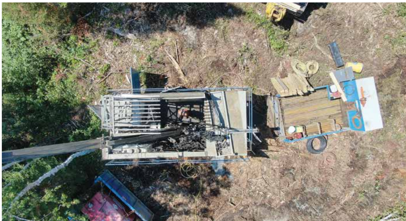
Foreuse en activité à Parbec vue d'en haut. / Drill rig at Parbec from above.
