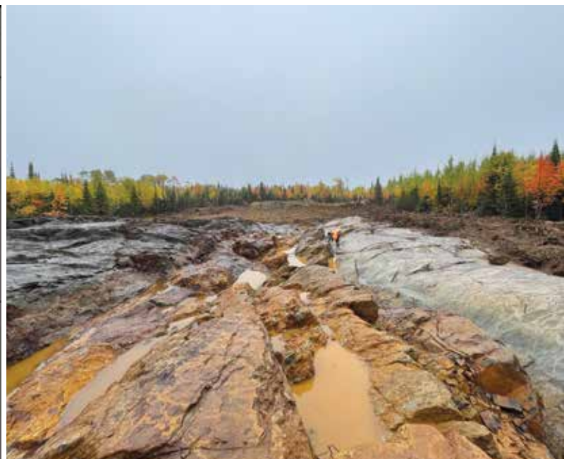
Décapage de la minéralisation de surface Victoria à Surimeau. / Stripping Victoria surface mineralization at Surimeau.
