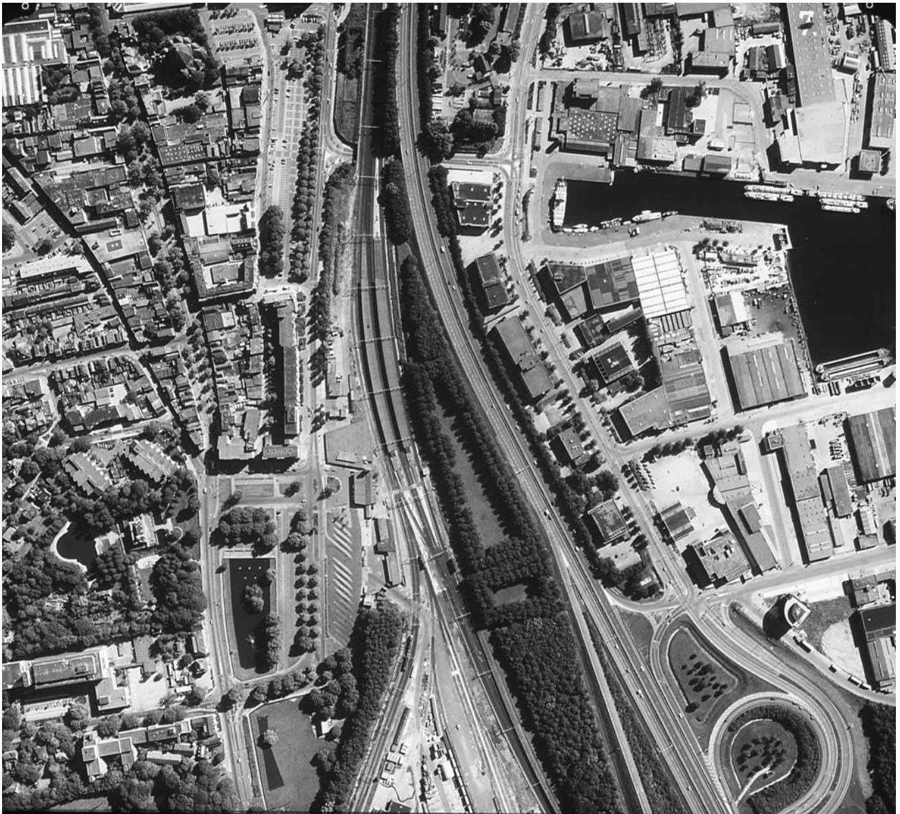
Aan de bouw van een nieuw station in Beverwijk (1960) werd de aanleg van een met bosvakken beplante strook gekoppeld tussen de perrons en de A22 met achterliggende havens. Sommige van deze bosvakken waren geheel ingevuld, andere omzoomd. Collectie Movares
