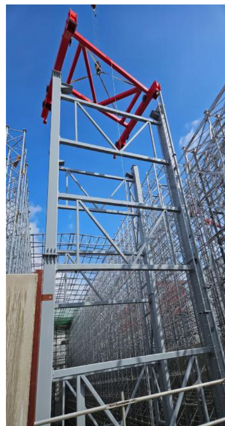
Transelevador BHB de 24 metros de altura en fase de montaje.
