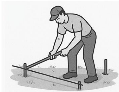
PASO 2: MARCAR A LINHA DA VEDAÇÃO
