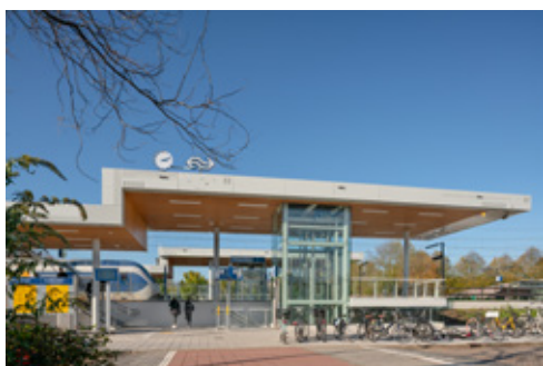
Perronkap Alkmaar Noord Architect: VenhoevenCS
