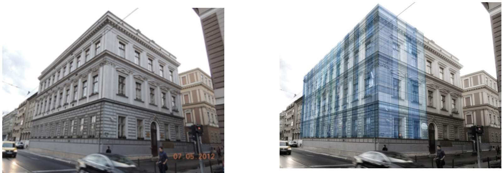
Fotografija 8.22. Drugi model transformacije u vidu staklenog plašta na ovojnici, potpuno transparentni dijelovi i dijelovi s integriranim fotonaponskim ćelijama, JU OŠ Safvet-beg Bašagić u Sarajevu, (a) postojeće stanje, (b) djelomično obložena fasadna struktura
