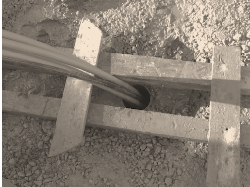
Fotografije 3.9. (a,b,c), Izgradnja niskoenergetske kuće u Sarajevu, projektant druge faze Haris Bradić, dipl. ing. arh., izvođenje geotermalnih bušotina, sustav sa četiri cijevi, fotografirano: 07.11.2012.
