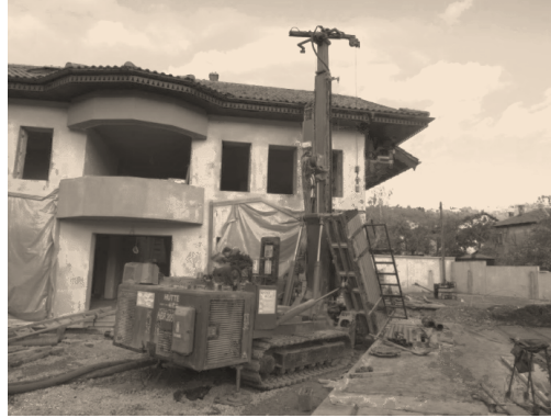
Fotografije 3.9. (a,b,c), Izgradnja niskoenergetske kuće u Sarajevu, projektant druge faze Haris Bradić, dipl. ing. arh., izvođenje geotermalnih bušotina, sustav sa četiri cijevi, fotografirano: 07.11.2012.
