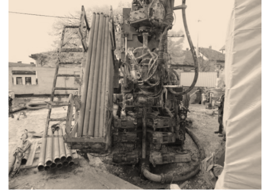
Fotografije 3.9. (a,b,c), Izgradnja niskoenergetske kuće u Sarajevu, projektant druge faze Haris Bradić, dipl. ing. arh., izvođenje geotermalnih bušotina, sustav sa četiri cijevi, fotografirano: 07.11.2012.
