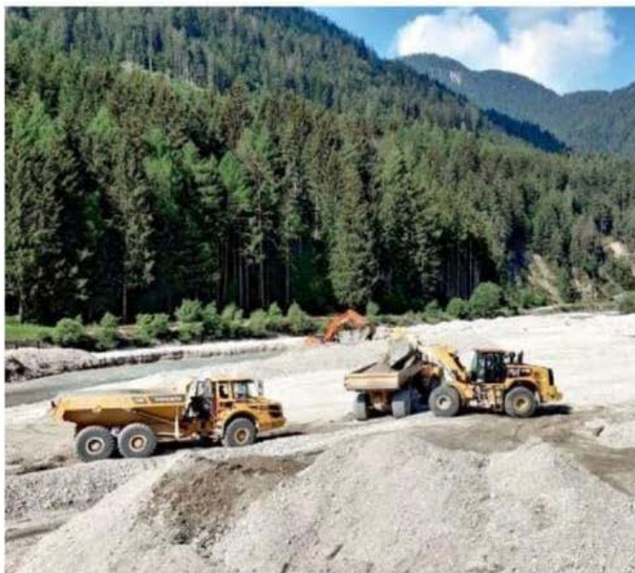
Un cantiere cadorino della Fratelli De Pra di Ponte nelle Alpi
