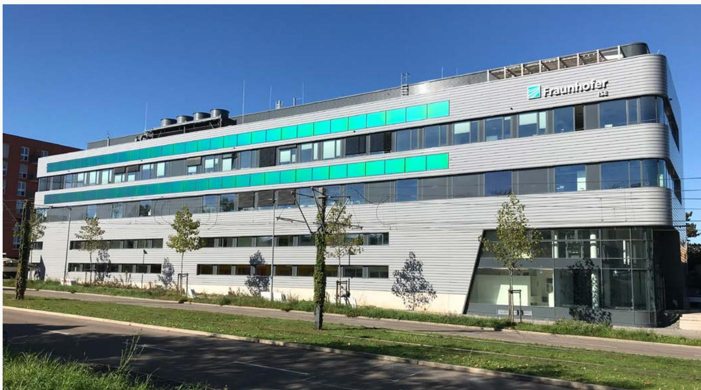
Zentrum für Höchsteffiziente Solarzellen am Fraunhofer ISE, Freiburg. MorphoColor-Module (grüner Farbstreifen) in einer Vorgehängten Fassade.
