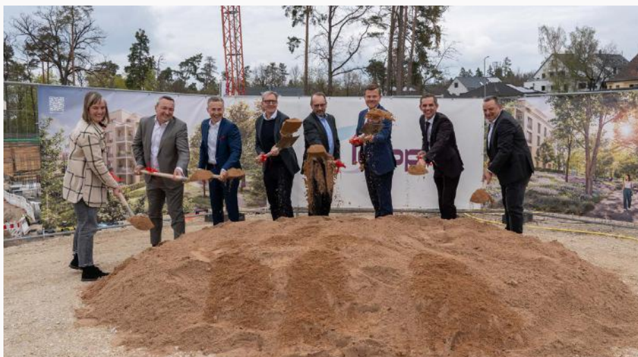
Spatenstich auf der ehemaligen Radrennbahn in Reichelsdorf (v. l. n. r.): Konstanze Engert (Maier Neuberger), Andreas Scheibl (HVB Unicredit), Matthias Wittmann (Sparkasse Nürnberg), Maximilian Maier (Maier Neuberger), Rainer Bargenda (HI Wohnbau), Oberbürgermeister Marcus König, Sebastian Greim (ECKPFEILER), Roland Eberhart (implenia)
