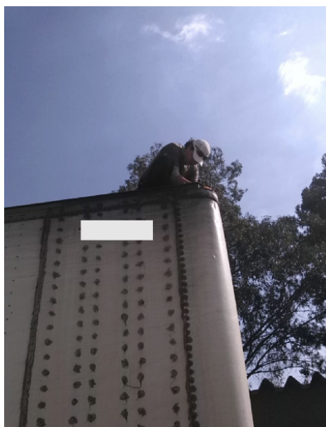
Fig. 1.2 Reparación de una caja seca después del resultado de la prueba de agua (parte superior)
