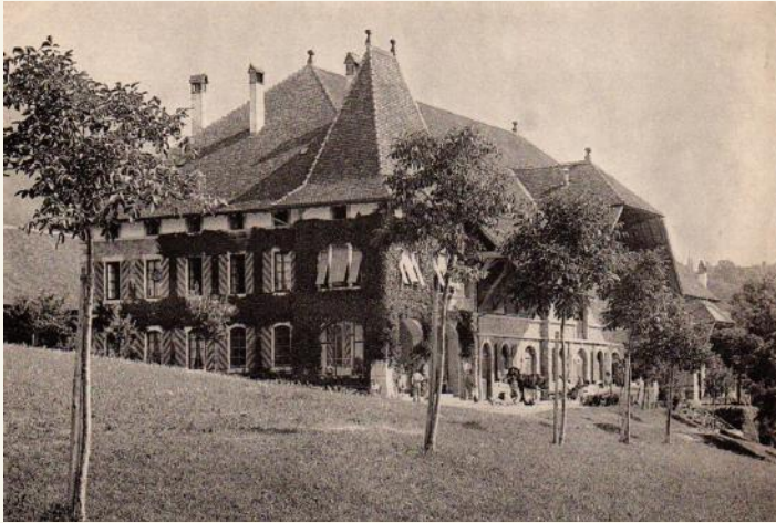
Ancienne ferme du Château de Gorgier
