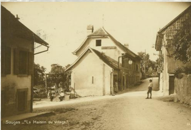
Sauges, « la Maison du Village »,
