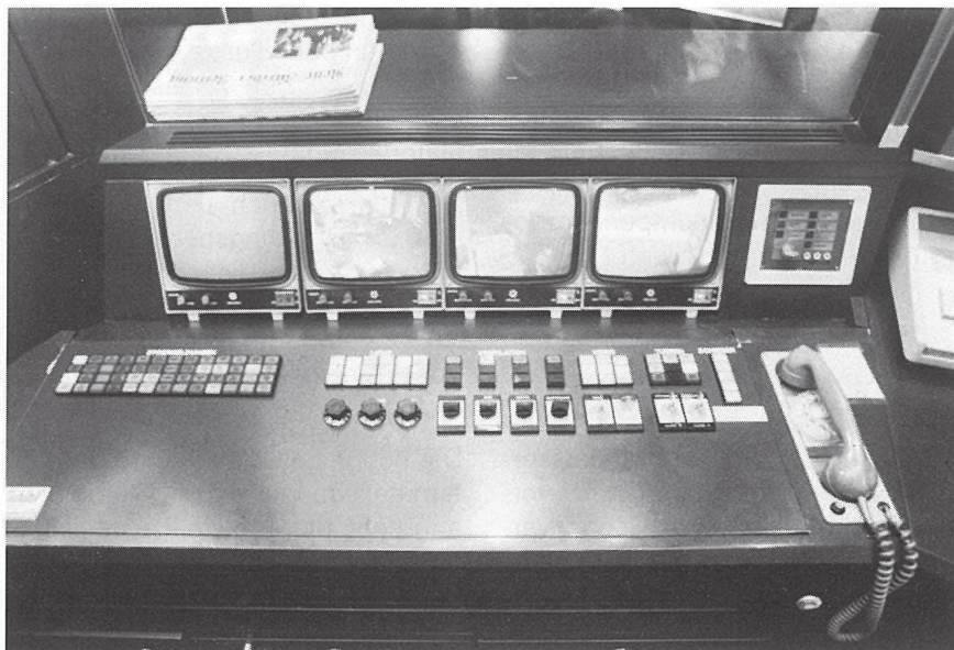
Bedienungs- und Anzeigepanel mit Störmelde- und Monitoranlage.
