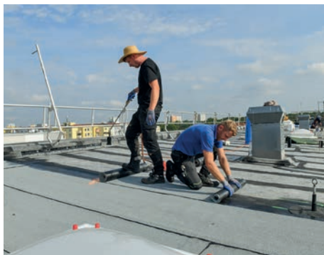
Auch im Ernst-Lubitsch-Weg 6-10 wird das Dach saniert
