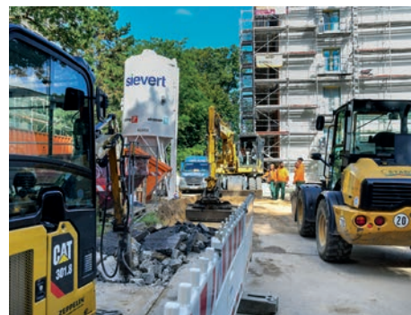
Zum Jahresende fallen die Gerüste
