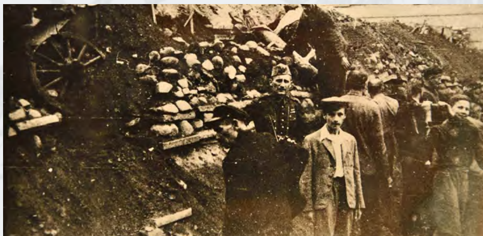
Budowa barykady na ul. Dobrej. Por. „Kazik”, przed nim jego syn „Gołąb”.
