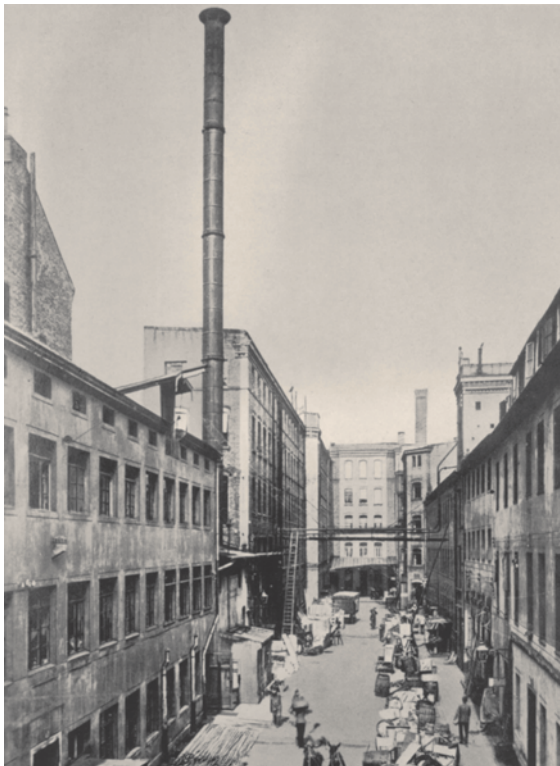
Fabrikhof von Siemens & Halske, um 1886
