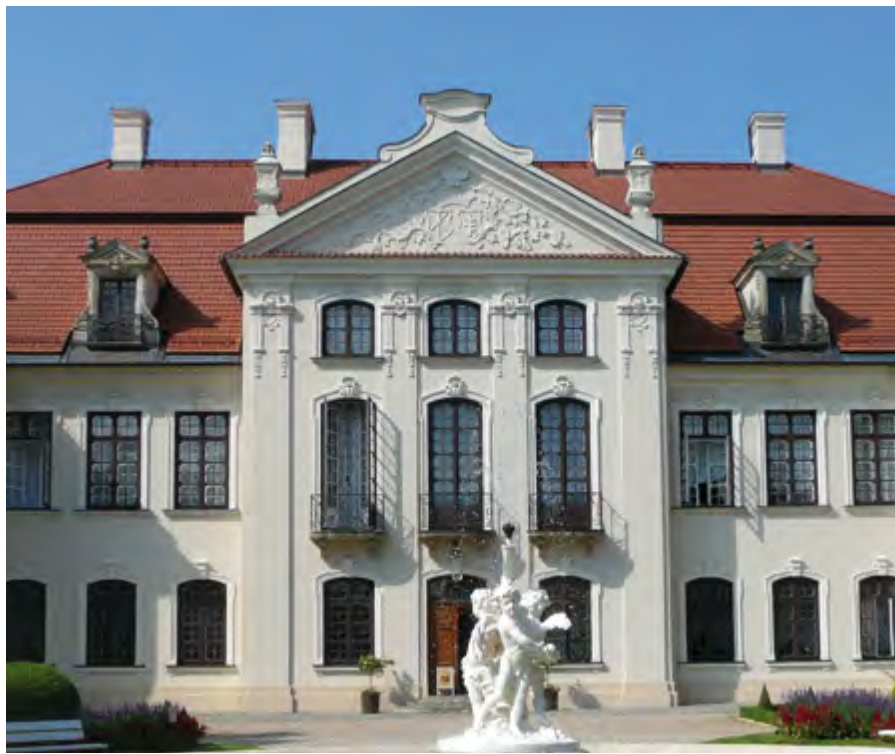
Façade arrière du palais
