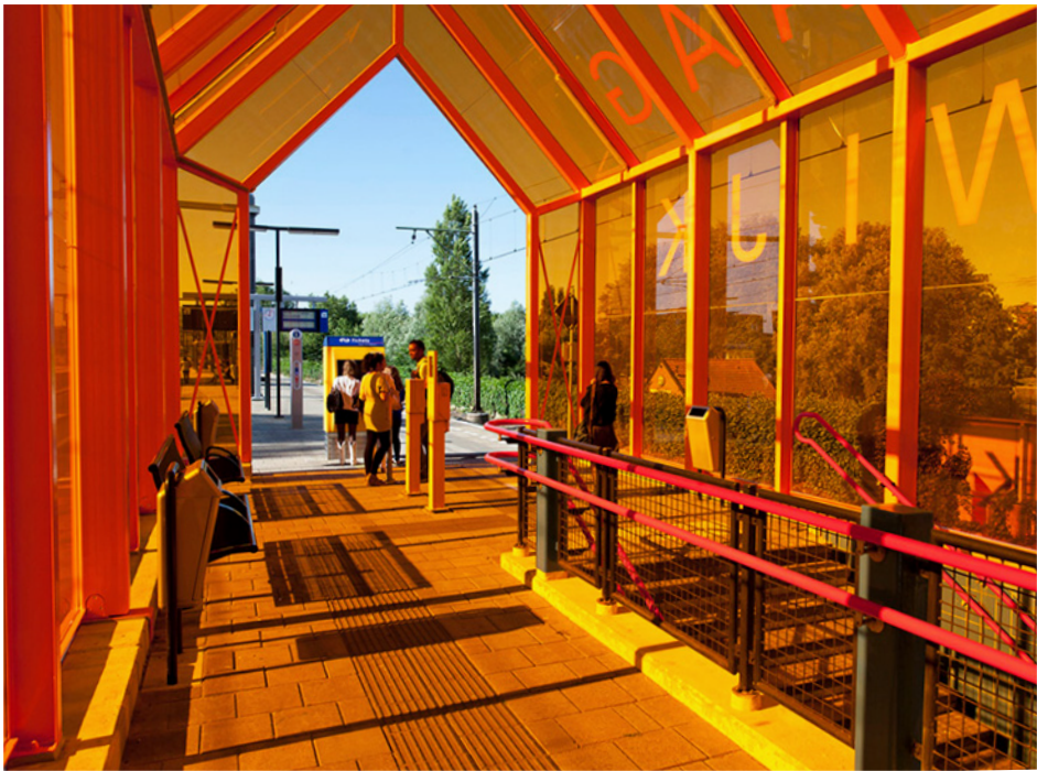
Kleur en licht Station Den Haag Moerwijk
