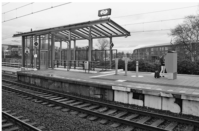
Station Den Haag Moerwijk, oude situatie
