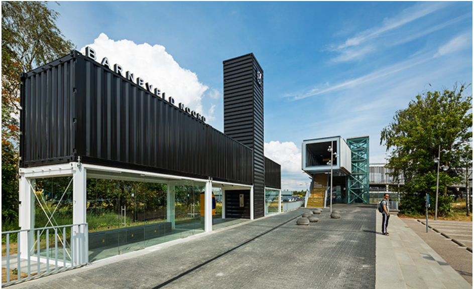
Station Barneveld Noord Een semi-permanent stationsgebouw van containers met helder uitzicht en een spectaculair hoog toilet
