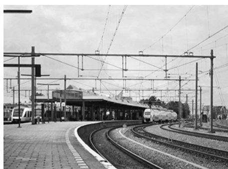
Station Zutphen, huidige situatie exterieur en interieur
