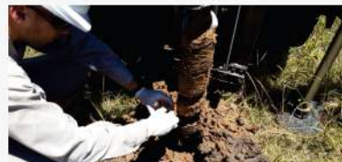
Inspecciones de Tanques de Almacenamiento de Combustibles
